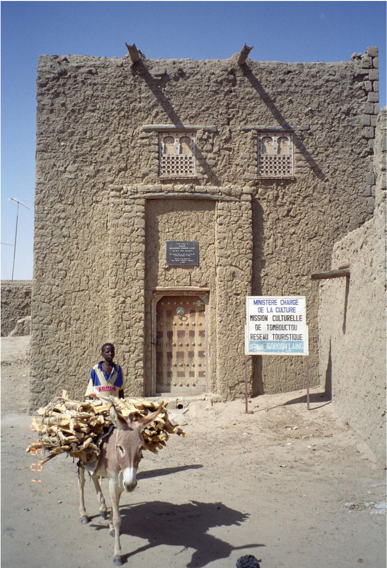
Timbuctù (Mali), la casa dove dimorò l'esploratore inglese Gordon Laing (Luca Lupi 1995)
